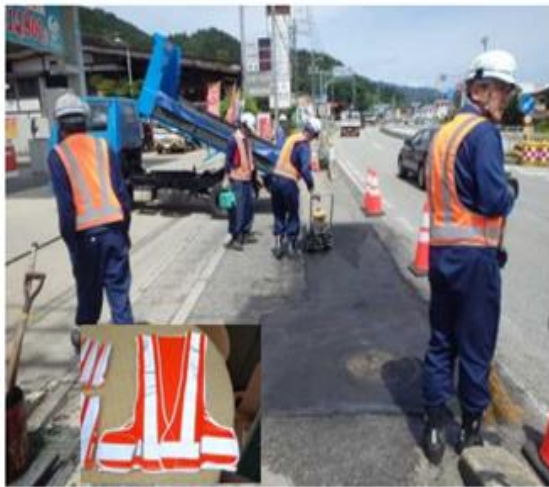
▲速乾性及び通気性の良い安全チョッキ 建設現場における熱中症対策事例集（国土交通省）より
